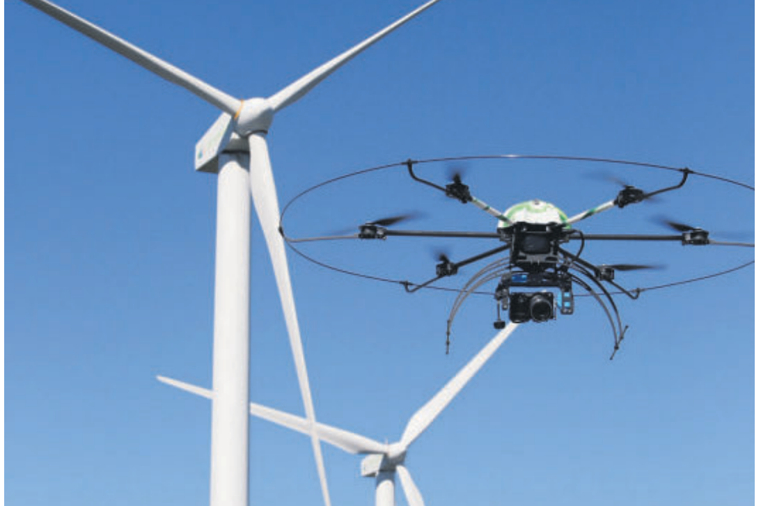
El dron aracnóptero inspecciona los molinos del parque eólico Sierra Dueña en Salamanca. / REPORTAJE GRÁFICO: IBERDROLA
